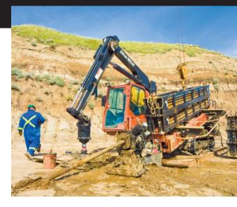
Les services de Forage Directionnel de Clean Harbors proposent des opérateurs expérimentés et des équipements techniques pour réaliser des forages d'une longueur maximum de 1.000 mètres, avec des conduites d'un diamètre maximum de 36 pouces.
